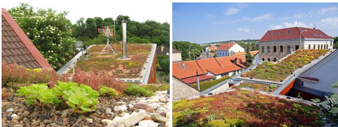
Obr. 8 Zelená střecha – Dům v úžině [47]
